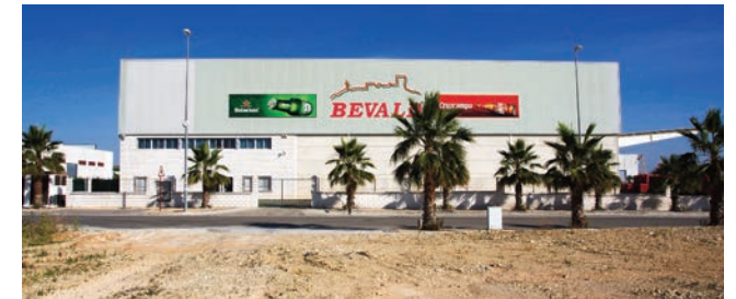
INSTALACIONES DISTRIBUCIÓN BEBIDAS - Jaén
