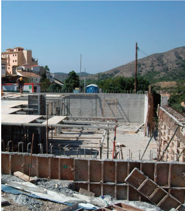
EJECUCIÓN DE OBRA Realización material del Proyecto
